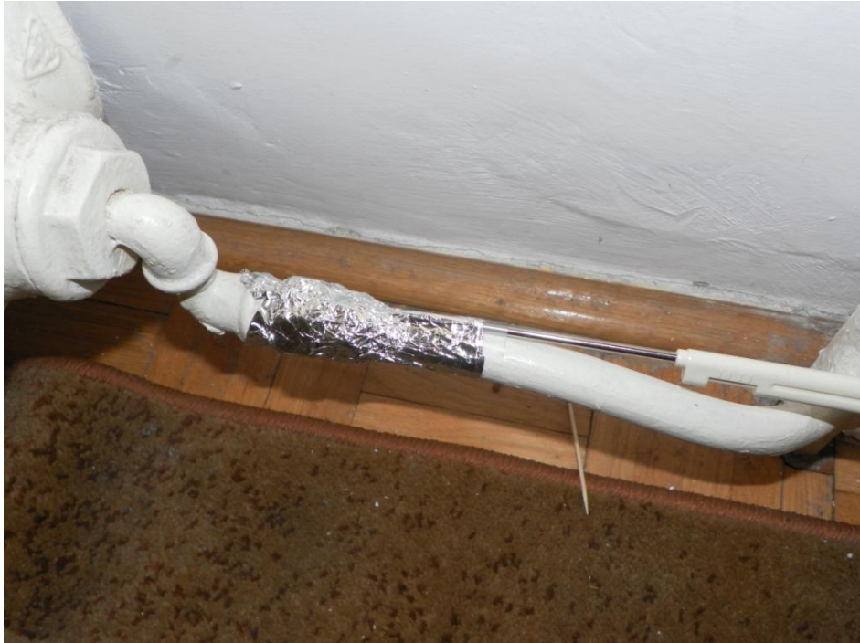
Owinięcie warstwami folii aluminiowej
